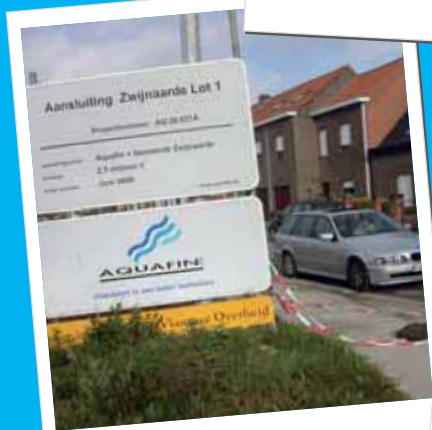
Collectorenwerken in Zwijnaarde
